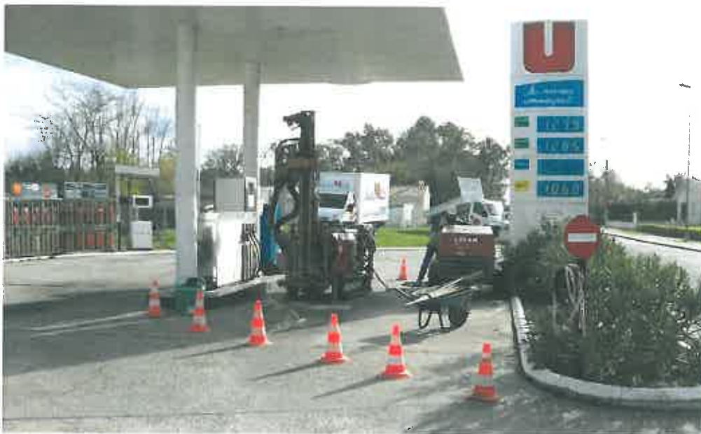
Figure n°6bis : Réalisation du sondage S2.
